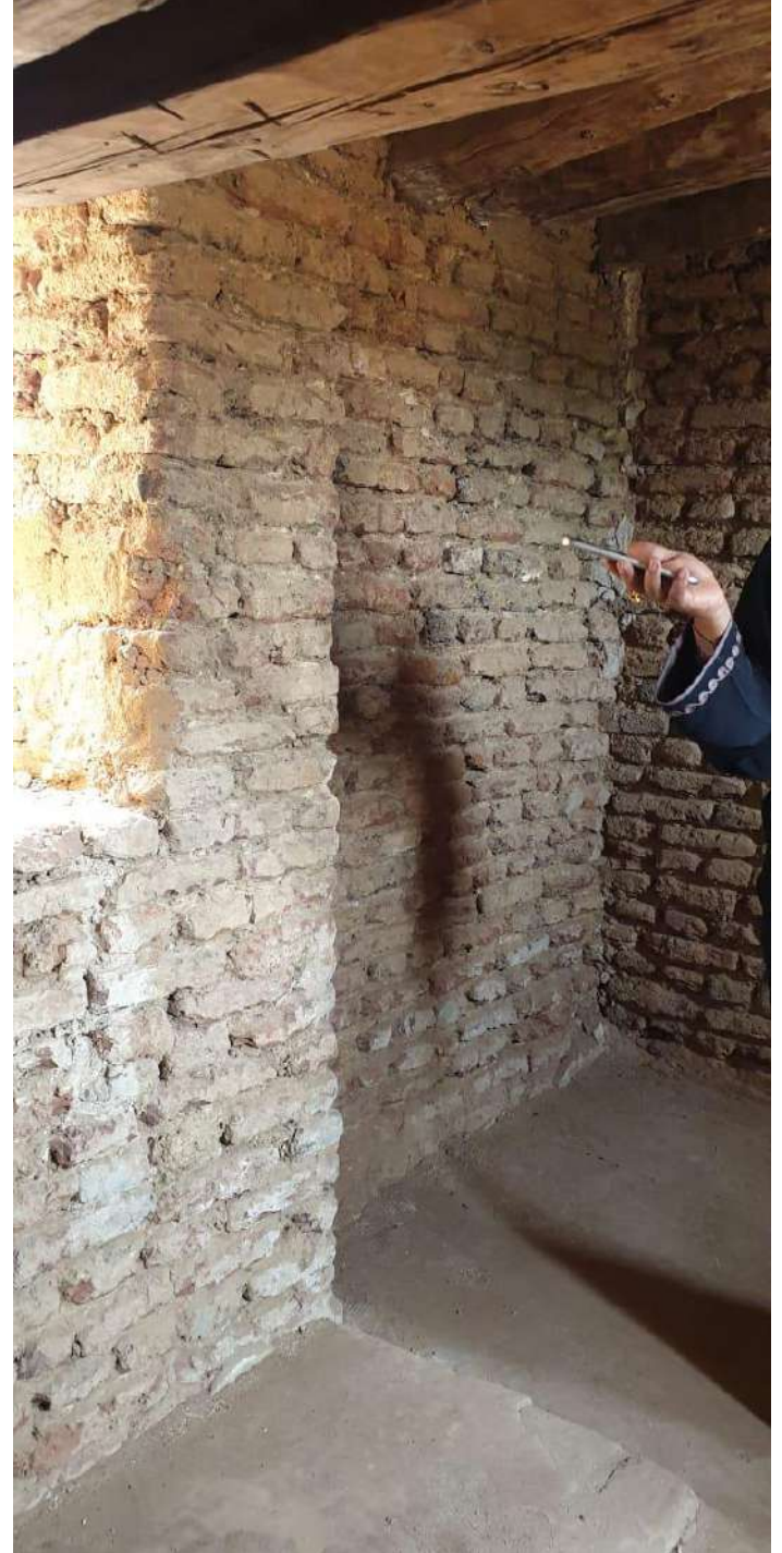
ترميم الحوائط: يتم باستخدام مواد أولية شبيهة بمواد البناء الاصلية.
